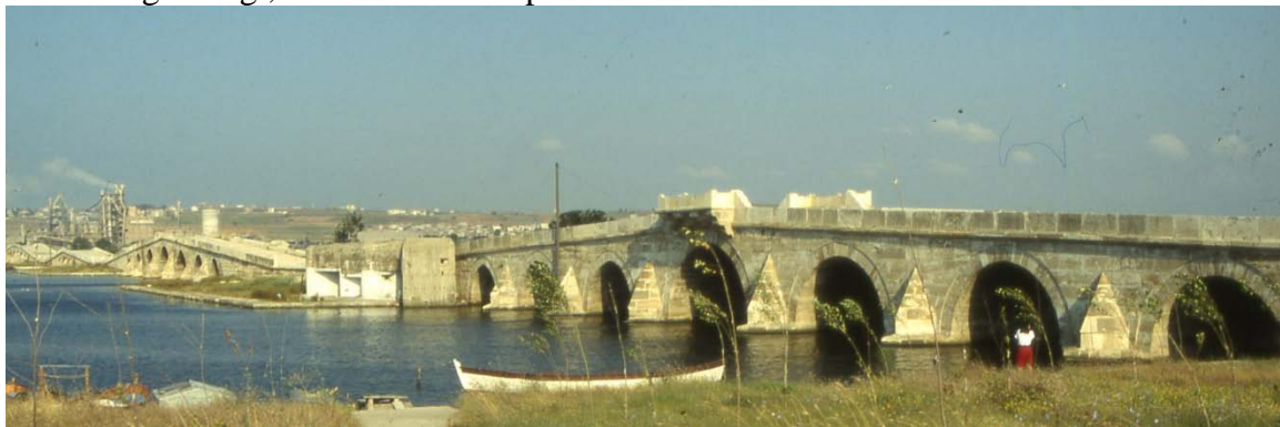
Figure 2 Büyükçekmece bridge on the pier of the lake in İstanbul/Türkiye (Photo: Ü. Öziş)
